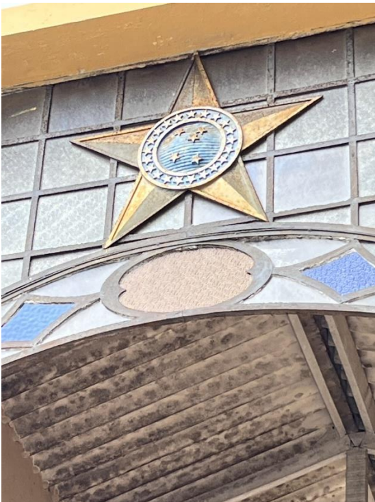
Detalhe do BRAZÃO sobre caixilho metálico no vão central do Pórtico do HGA.
