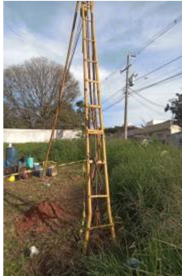
FOTO 2 – EXECUÇÃO DA SONDAEM
