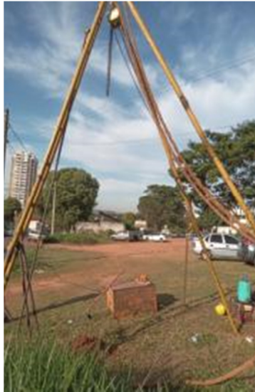
FOTO 1 – EXECUÇÃO DA SONDAEM
