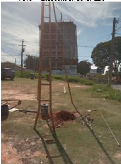
FOTO 4 – EXECUÇÃO DA SONDAEM
