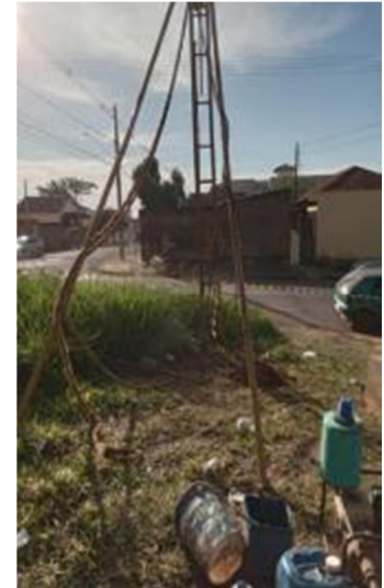
FOTO 3 – EXECUÇÃO DA SONDAEM
